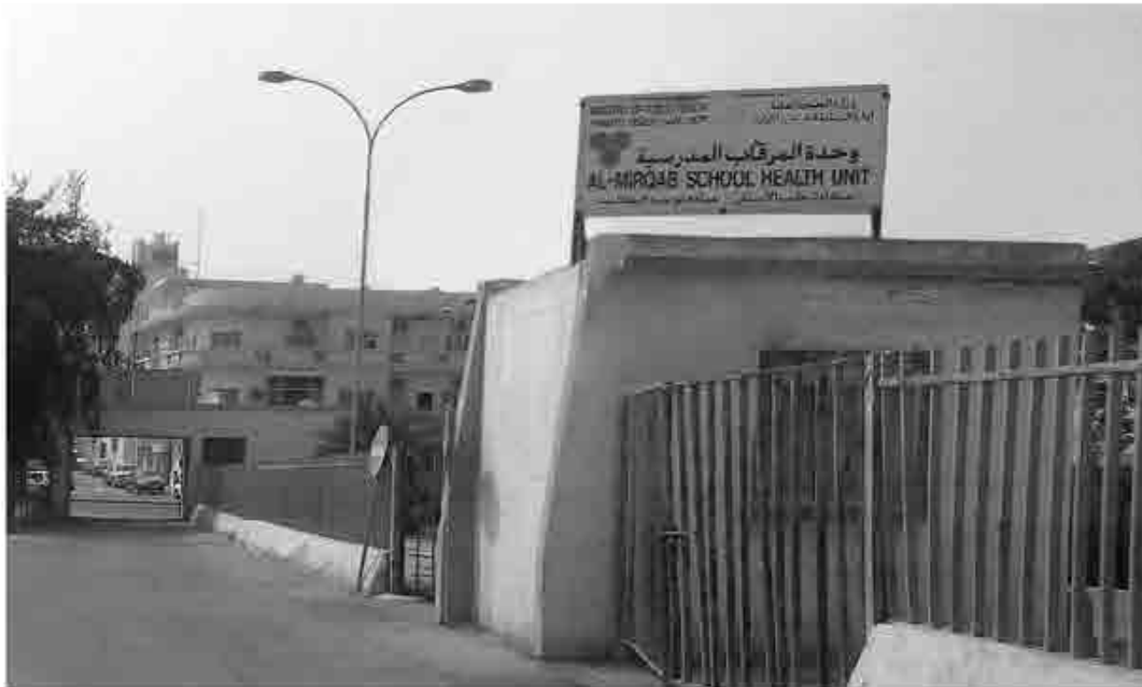
وحدة الصحة المدرسية بعد تحويلها لاحقاً لوحدة المراقبة ونقل تبعتها لوزارة الصحة العامة
